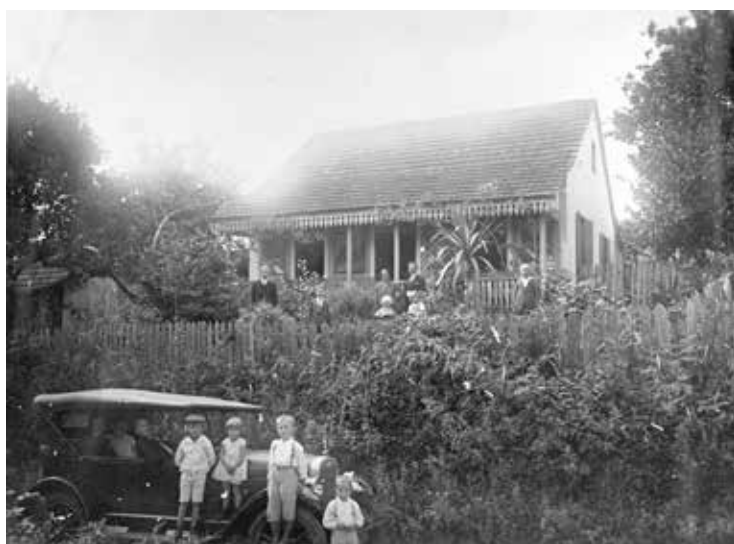
Residência de Estanislau Mickosz, por volta de 1920. No local atualmente está o Colégio Sebastião Saporski. Bairro Abranches/Taboão, Curitiba/PR. Fonte: Acervo Casa da Memória/Fundação Cultural de Curitiba/Mieszkanie Stanisława Mickosza, około 1920 r. W tym miejscu obecnie znajduje się Liceum im. Sebastiana Saporskiego. Dzielnica Abranches/Taboão, Kurytyba/Parany. Źródło: Zbiory Domu Pamięci/Fundacja Kulturalna w Kurytybie.
